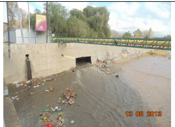
Figura 16. Desembocadura del by pass del canal Jarillal sobre el Zanjón Frías. Este by pass sería muy útil durante las tormentas convectivas, para evitar que el ingreso de las descargas aluvionales provenientes del oeste de Godoy Cruz, a través del Canal Gorriti, se agregue al sistema de riego, aguas abajo de la compuerta de la figura anterior.
