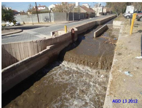
Figura 9. Vista de la obra civil preparatoria para recibir un sistema de rejas para la intercepción de los RSU en el canal Jarillal, aguas arriba del puente canal sobre el Zanjón de Los Ciruelos. La rejas de dos etapas serán ejecutadas en los próximos dos presupuestos anuales. Si bien cuenta con un aliviadero en margen derecha, la compuerta del descargador no está automatizada.
