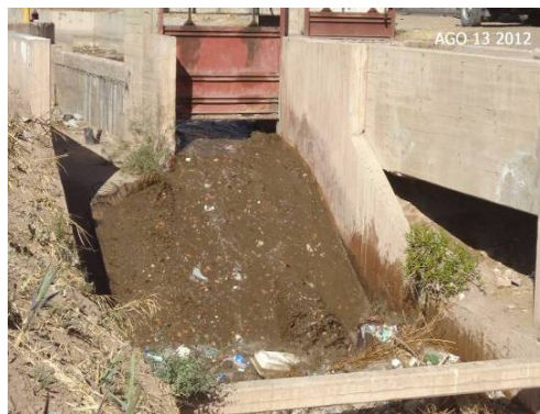
Figura 10. Fotografía de la descarga al Zanjón de los Ciruelos de los caudales iniciales a fin de evitar el ingreso a los sectores aguas abajo del agua contaminada por la suciedad acumulada en el cauce durante los 105 días de corta anual del año 2012. El descargador solamente cuenta con un volante de accionamiento manual. Debería preverse su motorización, defensa antivandálica y su automatización.
