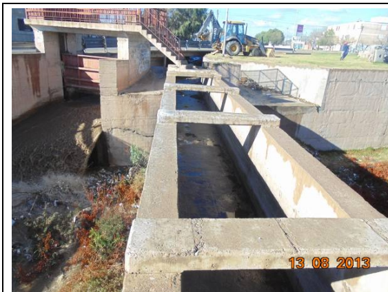
Figura 13. Sistema de limpieza, descargador y canaleta sobre el Zanjón Maure del Canal Jarillal. Aunque el sistema está protegido contra el vandalismo y posee motorización, le estaría faltando la automatización y manejo a distancia de la compuerta.
