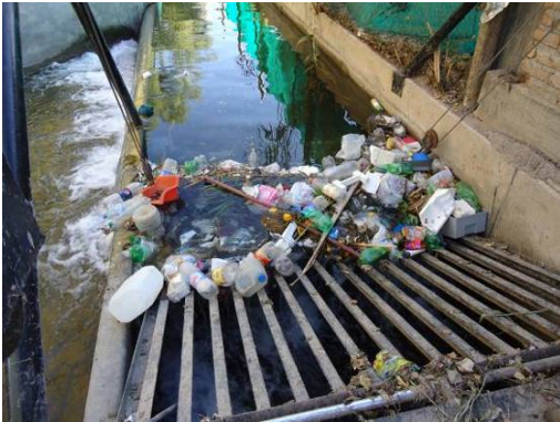
Figura 11. Sistema de Trampa de Basura, previamente a ser mantenido. Puede observarse la curva de remanso hacia aguas arriba. El diseño más moderno y de mayores dimensiones permitirá la instalación experimental de un motor para aumentar la velocidad de izaje y los trabajos de limpieza de la reja. Trampa en el Canal Jarillal, aguas arriba del sifón de cruce debajo del Zanjón Frías.
