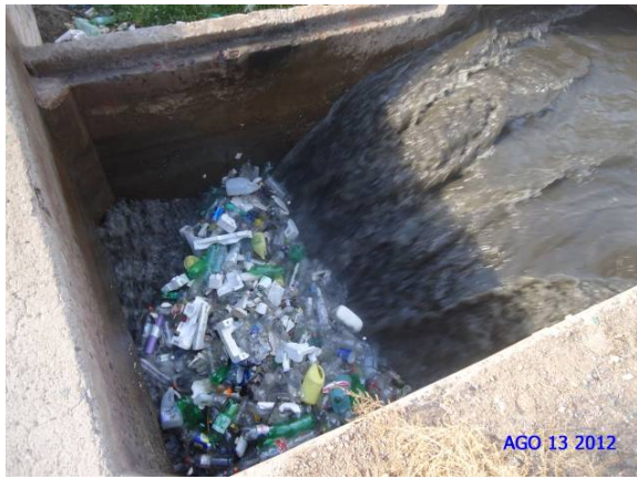
Figura 7. Vista de la cámara de carga del sifón del Canal Jarillal bajo el zanjón Frías durante los primeros instantes luego de la corta de riego.
