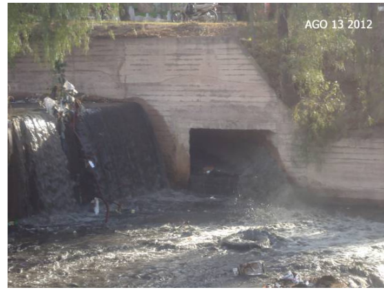
Figura 8. Vista del desagüe del sifón del Canal Jarillal hacia el cauce del Zanjón Frías, canal de desagües pluvioaluvionales, que toma las escorrentías provenientes del piedemonte y de gran parte de la ciudad de Godoy Cruz.
