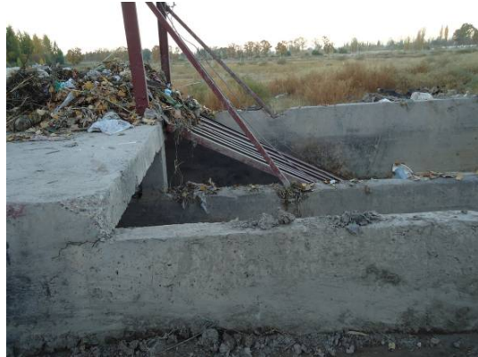
Figura 12. Sistema de dos etapas en la progresiva 20.000 desde su nacimiento en el Dique Carrodilla, previo a un sifón de muy baja pendiente, cuya cámara de carga también posee una reja auxiliar, ya que la incidencia de los RSU es demasiado intensa y se hace necesario una tercera y cuarta etapas para poder disponer de tiempo antes que el sistema se atarquite totalmente. El sistema de rejas también puede ser motorizado experimentalmente mediante el mismo sistema que poseerá la sección de control de basura de la fotografía anterior. Esta imagen puede complementarse con la Figura 4.
