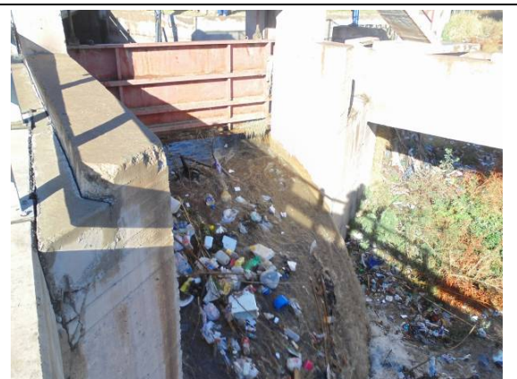
Figura 5. Compuerta de limpieza abierta, durante el inicio del riego del ciclo hidrológico 2013. La cantidad de Residuos, elementos de todo tipo y sedimentos es muy apreciable. Este lugar es un punto muy importante para poder aliviar y facilitar la autolimpieza durante una crecida aluvional.
