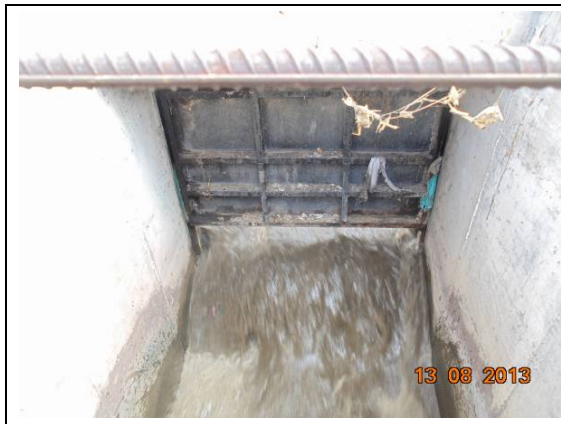
Figura 15. Compuerta que, cuando se cierra, se acciona el by pass hacia el Zanjón Frías. No posee accionamiento motorizado, automatismo ni protección antivandálica. Los actos vandálicos en este sitio podrían ser mayor, debido a que se encuentra en un sector el que no es muy visible desde la vía pública.
