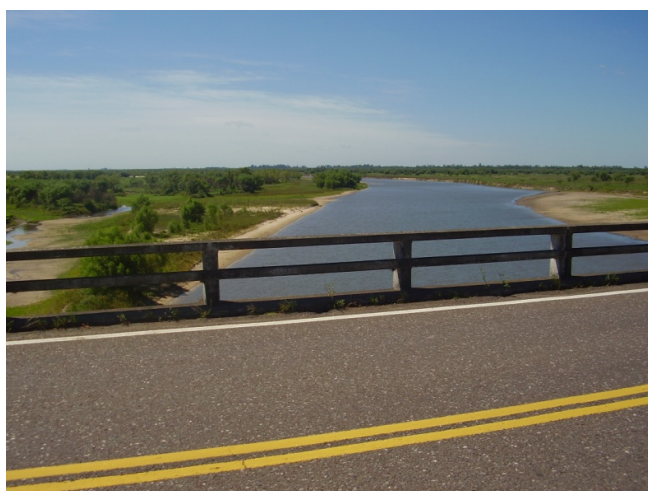
Figura 5. - Río Corriente y ruta provincial 123 - Paso Lucero (S 28° 59' 39,5"; W 58° 33' 32,3)
