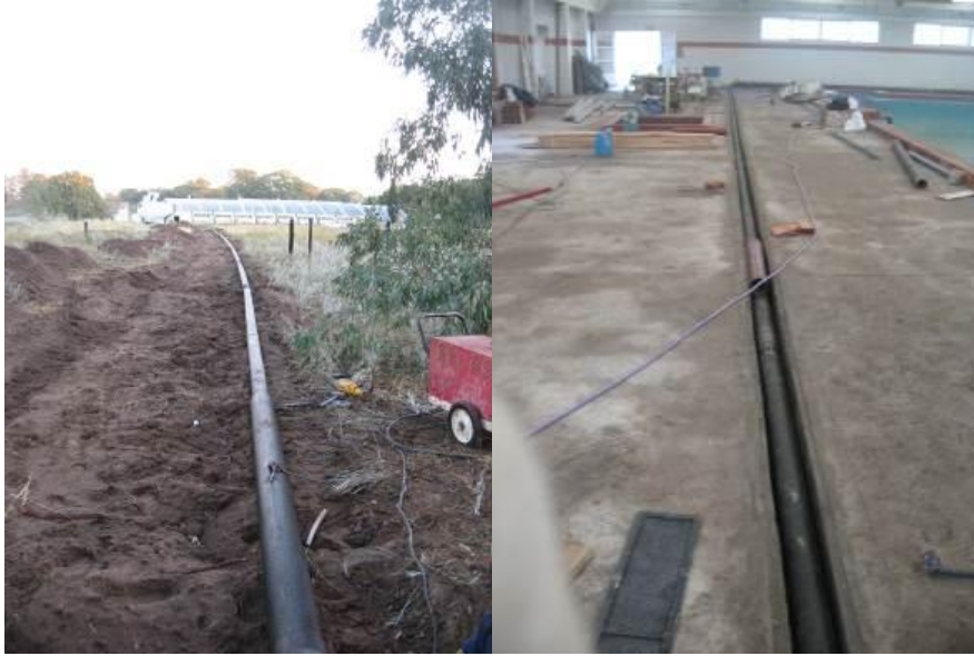
Figura 3. Tendido del sistema de cañerías
