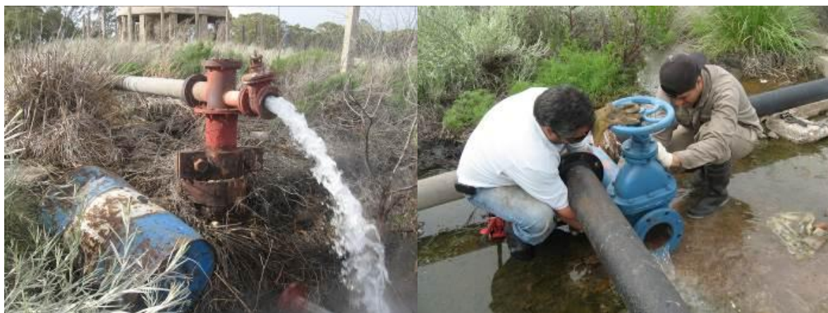
Figura 2. Montaje en campo del sistema de cañerías
