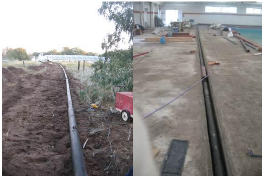
Figura 5. Tendido de cañería en campo y dentro del natatorio
