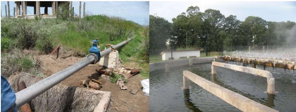
Figura 3. Reemplazo de accesorios y sistema de enfriamiento
