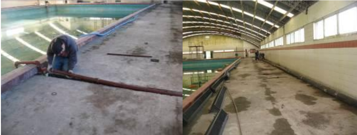
Figura 6. Instalación de cañería dentro del natatorio
