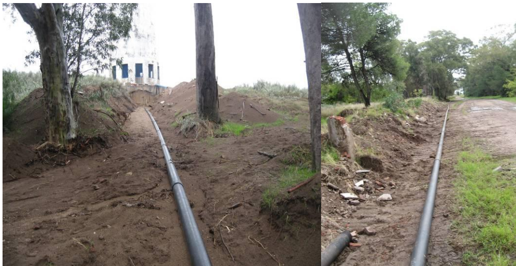
Figura 2. Tendido de cañería en campo
