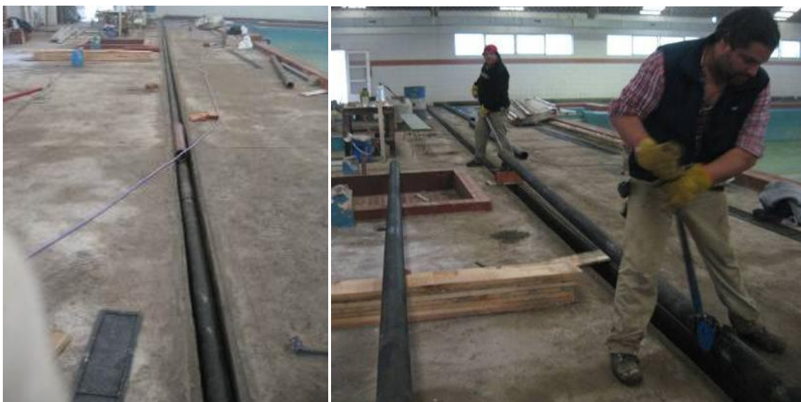
Figura 5.- Instalación del sistema de distribución de agua en el natatorio
