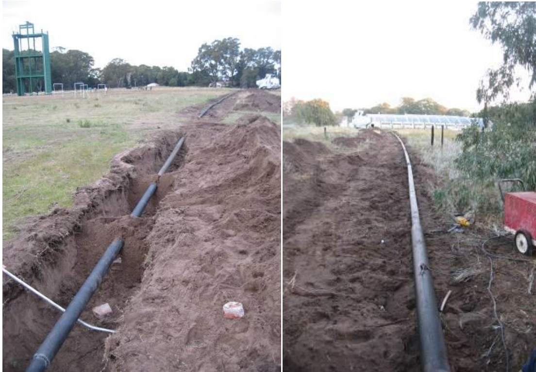
Figura 3.- Tendido de cañerías en el terreno
