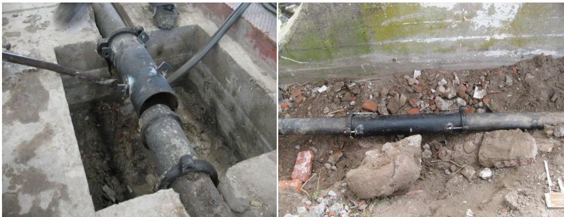
Figura 4.- Instalación de juntas de dilatación en el natatorio
