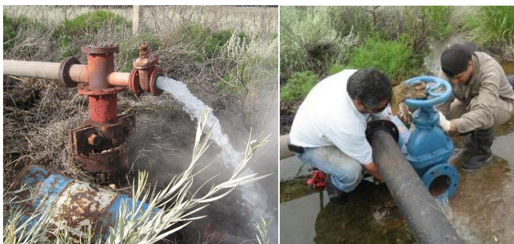
Figura 2.- Montaje en campo
