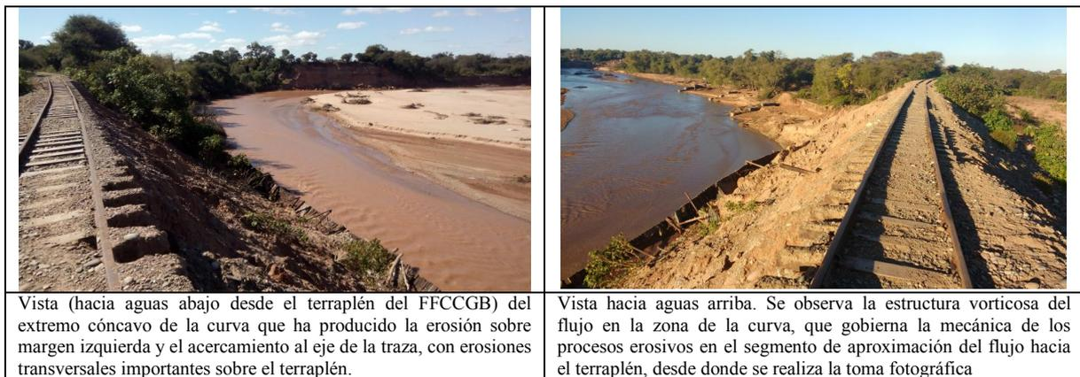
Vista (hacia aguas abajo desde el terraplén del FFCCGB) del extremo cóncavo de la curva que ha producido la erosión sobre margen izquierda y el acercamiento al eje de la traza, con erosiones transversales importantes sobre el terraplén.
