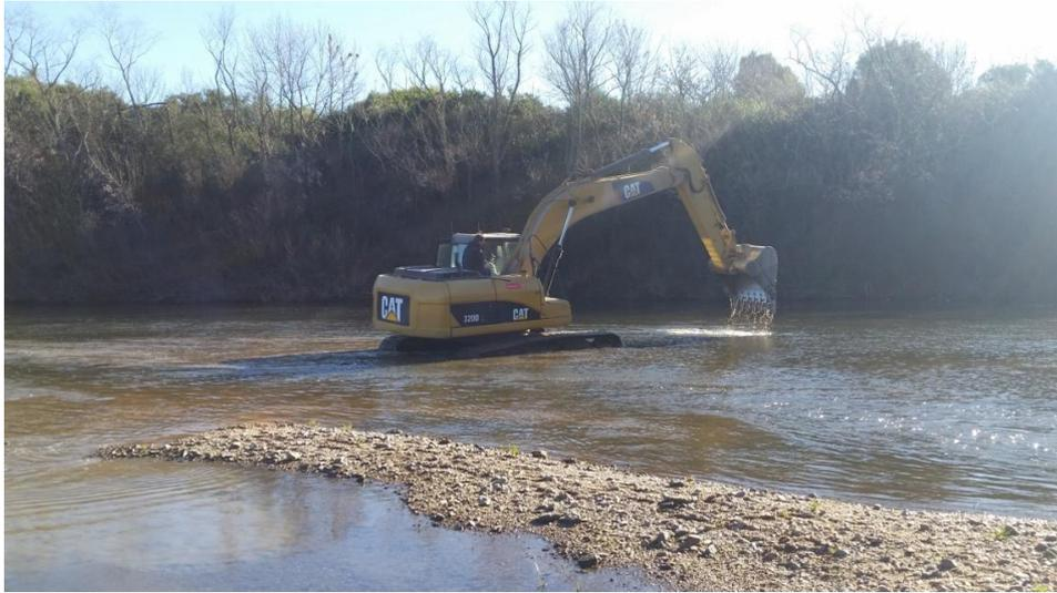
**Figura 3.-** Excavación de las trampas de sedimento mediante retroexcavadora.
