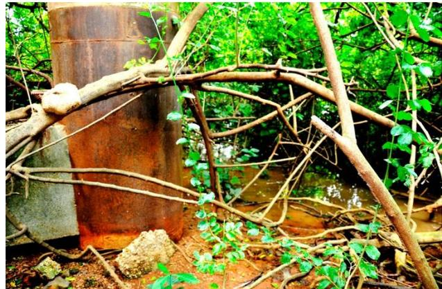
**Figura 16.** Canal Incipiente junto al Pilar de la Tercera Torre de Transmisión. (Foto: Wilson-Jr. 2017)
