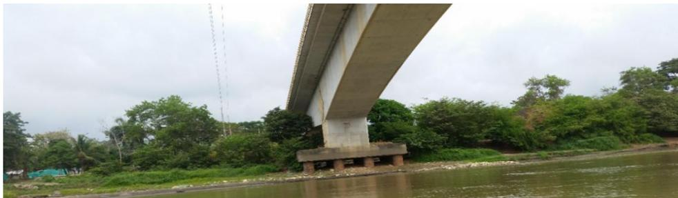
**Figura 14.-** Socavación en las pilas del puente sobre el río Sinú a la altura de Montería
