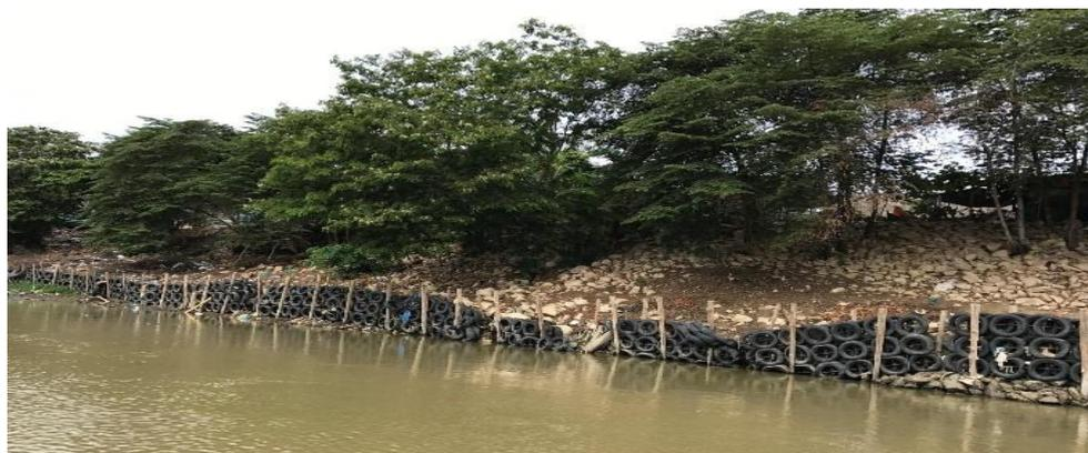
**Figura 16.-** Obras para controlar socavación lateral en el río Sinú
