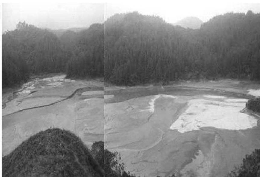
Figura 8.- Problemas de sedimentación en el embalse de Troneras. Fuente:
