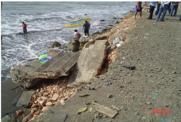
**Figura 10.-** Erosión por acción de las Olas
