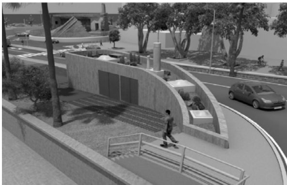
Figura 3.- Estación de bombeo de aguas residuales de San Andrés, España. (Fuente: de EMMASA, 2017)
