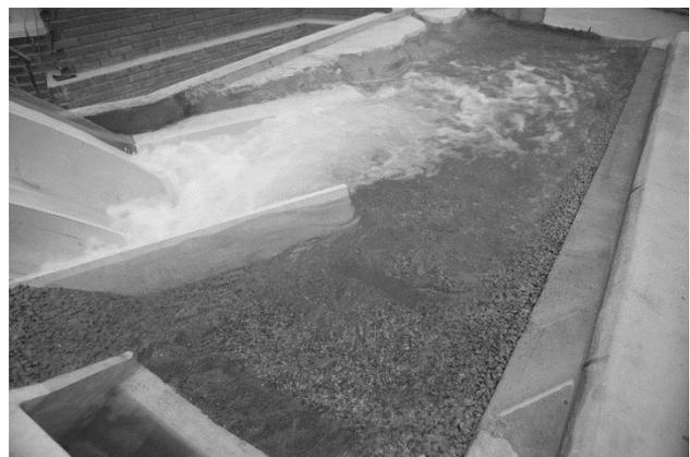
Figura 6.- Funcionamiento conjunto del aliviadero y la central.
