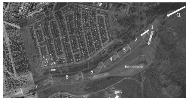
Figura 1.- Zona de estudio. La numeración indica las barreras decantadoras y las flechas la dirección del flujo. La flecha segmentada indica el desvío de parte del flujo hacia la hondonada.
