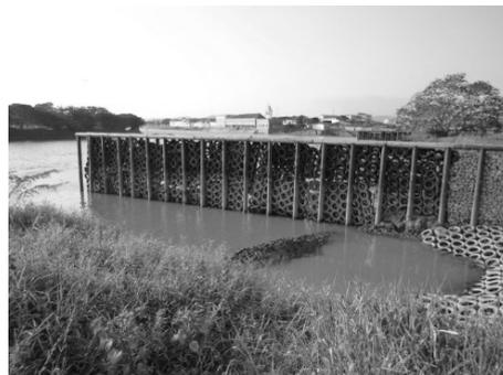
**Figura 7.-** Espolón permeable para protección de orilla en el río Sinú.
