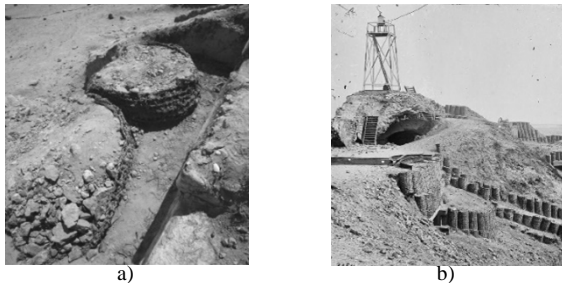
Figura 1.- Primeras aplicaciones de los gaviones: a) Caral gaviones de malla vegetal trenzada; b) guerra civil americana (FRACASSI, 2017).
