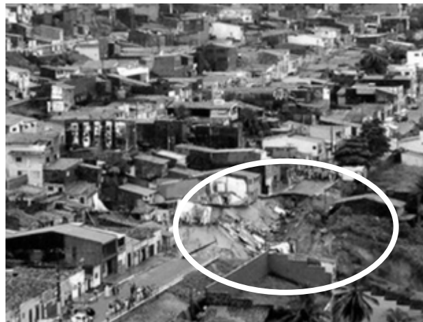
Figura 1.- Exemplo de Deslizamento em Natal/RN.
