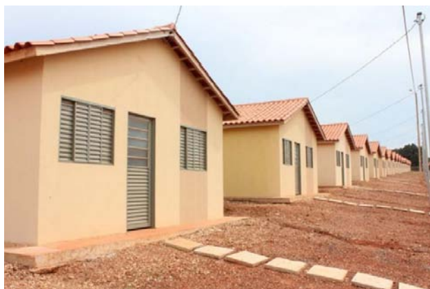
Figura 3.- Residências unifamiliares de padrão popular, com cobertura em laje de concreto armado e telhas cerâmicas.
