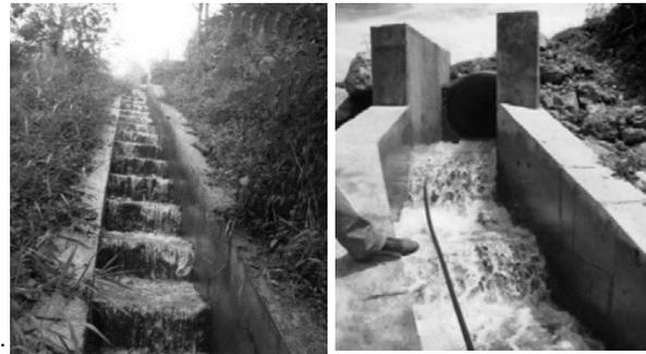
Figura 1.- Ejemplos de canales escalonados empleados en drenaje urbano.
