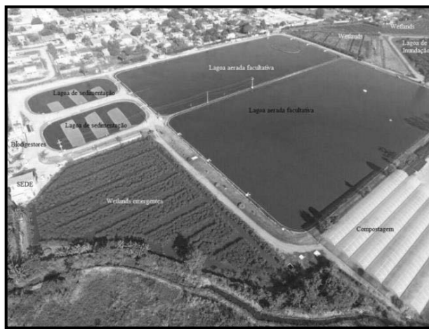
Figura 1.- Vista aérea da ETE Ponte dos Leites.
