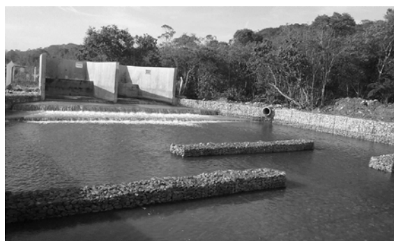
Figura 9.- Vista da bacia de dissipação em operação, já em vazão de 4,0 \text{ m}^3/\text{s} . (Autores, 2015)
