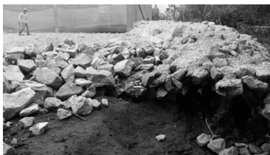
Figura 6.- Vista da erosão na bacia de dissipação, durante a realização dos testes com vazão restrita a 0,8 \text{ m}^3/\text{s} . Ao fundo, a caixa dissipadora da adutora de interligação, com suas operações paralisadas. (Autores, 2015)
