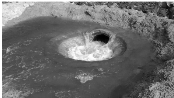
Figura 8.- Vista do “vertedor tulipa” provisório em funcionamento com vazão de 0,8 \text{ m}^3/\text{s} , durante a execução das obras de controle de erosões. (Autores, 2015).
