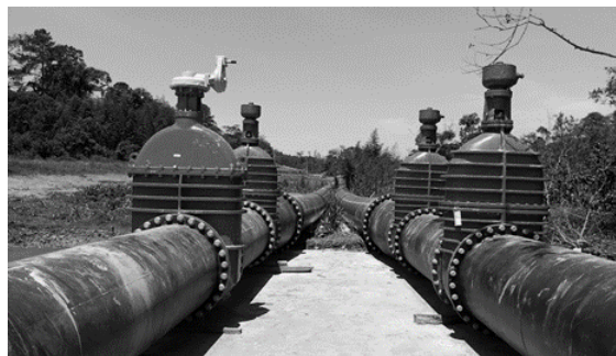
Figura 3.- Vista das linhas de adução em PEAD 1200 mm da Adutora de Interligação nas proximidades do seu desemboque (Autores, 2015).
