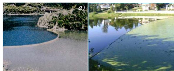
Figura 2.- Control de sedimentos y nutrientes en embalses. a) Cortina flexible en el Embalse Terauchi Dam, Japón. b) Barrera superficial provisoria en el Embalse San Roque.
