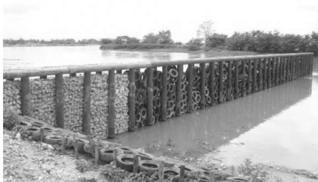
Figura 1.- Espolón construido para proteger la bocatoma de Lórica, Córdoba, Colombia.
