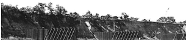
Figura 2.- Vista aguas arriba de espigones semipermeables.
