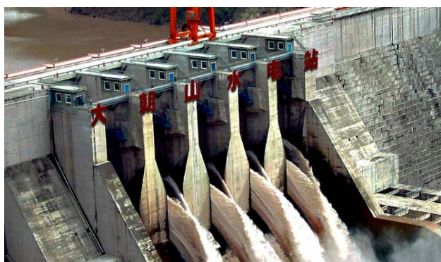
Figura 1.- Vetedouro da usina de Daschaoshan em operação
