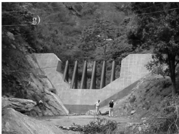
Figura 6.- Obra de retención para avenidas torrenciales, Venezuela.
