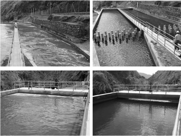
Figura 7-10.- Modificaciones hechas en los desarenadores.
