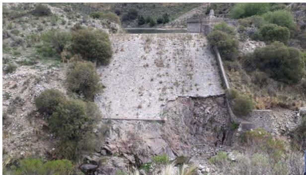
Figura 1.- Ventedero de descarga del Dique Los Alazanes posterior a la rotura por erosión.
