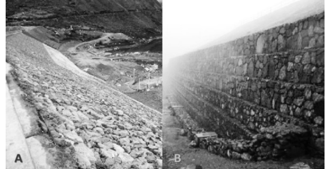
Figura 2.- A).- Colchones Reno. B).- Gaviones - Sistema Terramesh.
