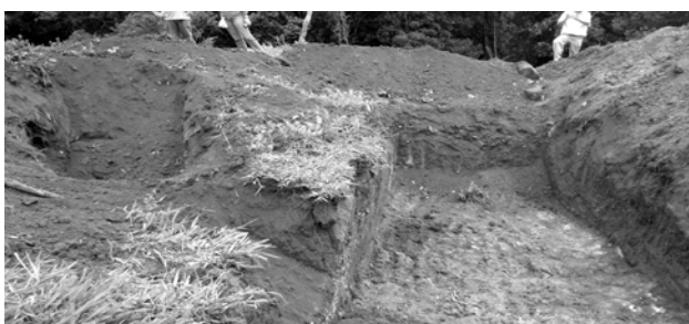
Figura 3.- Execução de uma bacia de contenção, para reter sedimentos na estrada principal.
