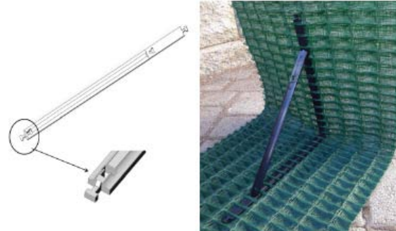
Figura 1.- Barras de compuesto de fibra se insertan a través del geomanto y amarradas de modo de formar una escuadra interna.
