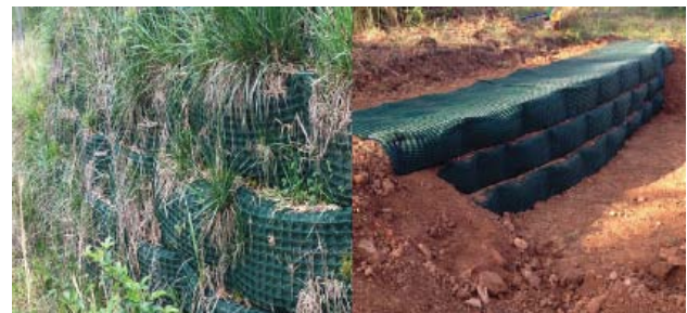
Figura 2.- Pyrawall construido y vegetado.
