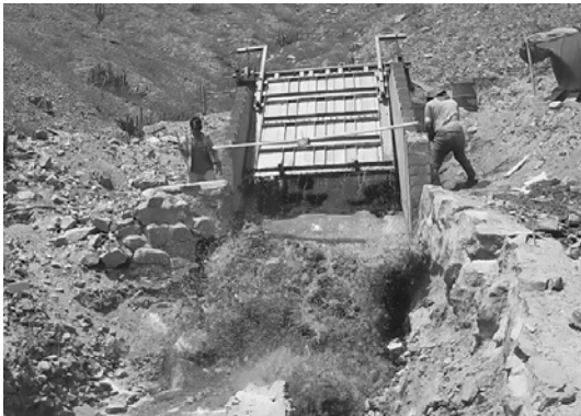
Figura 3.- Vista desde aguas abajo de la liberación súbita del volumen finito de la mezcla bifásica y generación de la onda de huayco.
