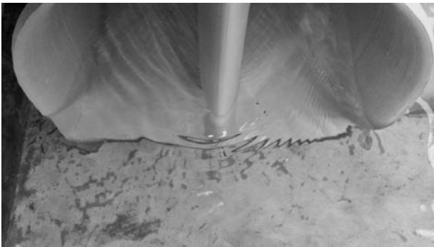
Figura 1.- Transición de entrada de túnel, con pila central, con recubrimiento catalizado para perfeccionamiento de superficie y protección contra intemperismo y operatividad Desarrollo.
