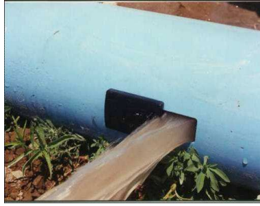
Foto n° 5: tubería con compuerta corrediza caudal constante
