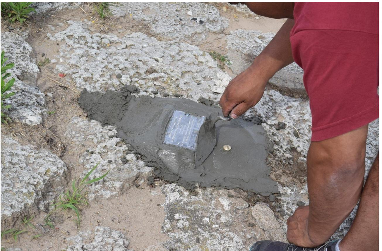
*Figura 6.101. Detalle de colocación de placa identificadora de bulón – San Pedro*
