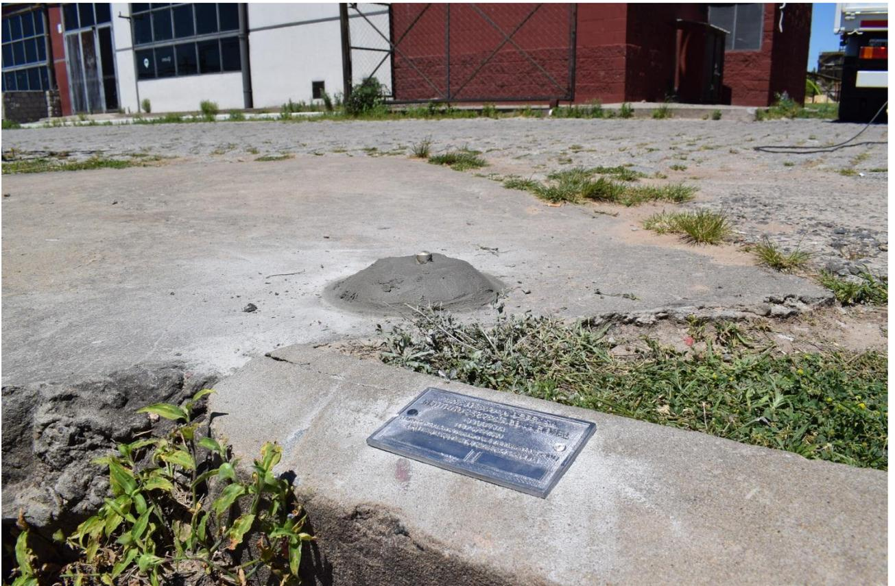
*Figura 6.34. Placa identificadora y bulón de nivelación - Ramallo*
