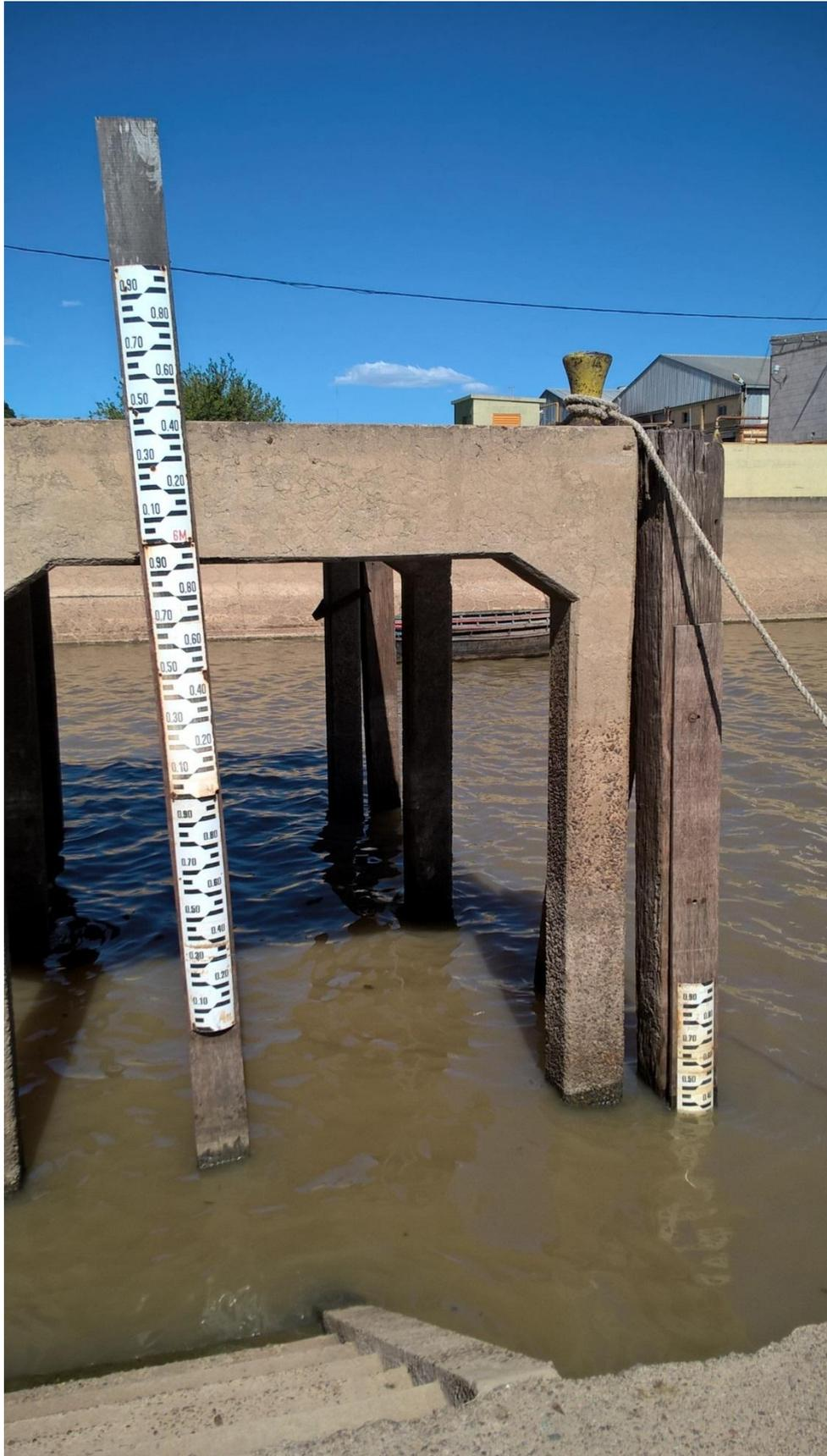
*Figura 6.81. Detalle escala hidrométrica- Victoria*
