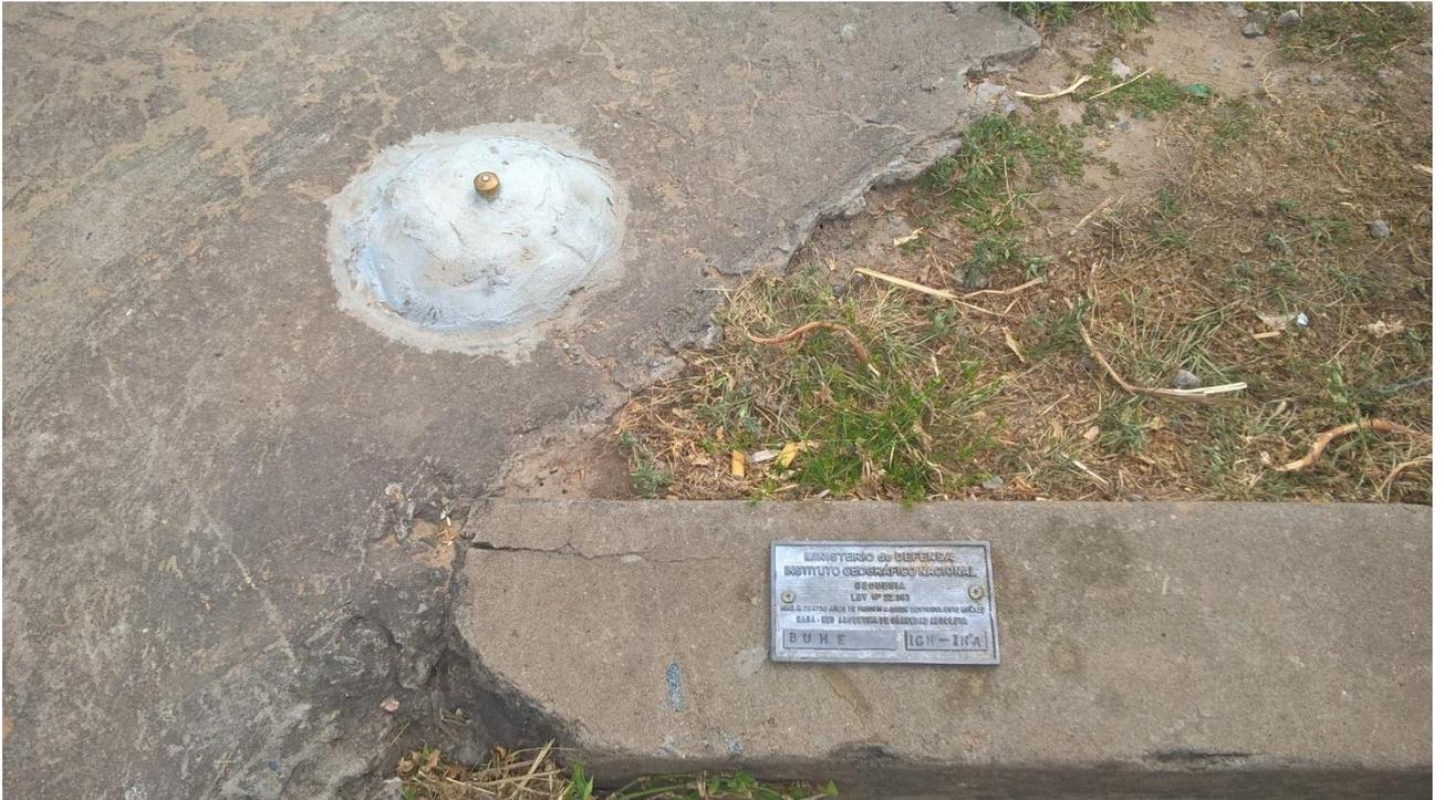
*Figura 6.35. Placa identificadora y bulón de nivelación - Ramallo*
