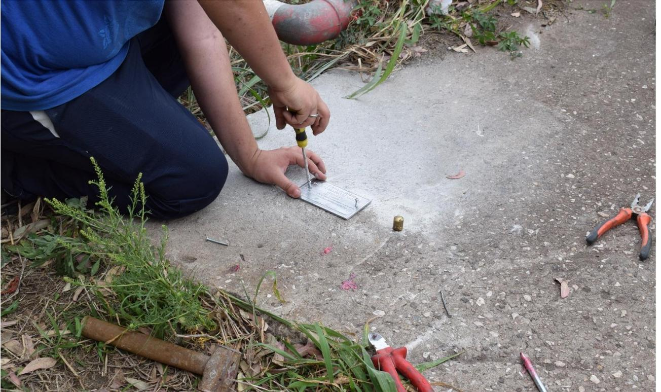
*Figura 6.86. Colocación de placa identificadora de bulón – Rosario*
