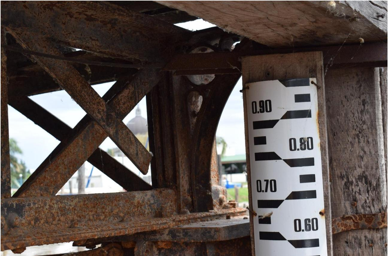
*Figura 6.38. Detalle escala hidrométrica – San Nicolás*
