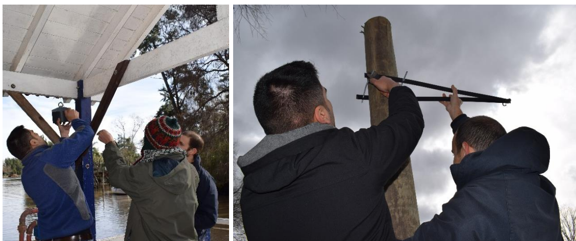
Figura 10.- Instalaciones de Sensores en Río Carapachay y Arroyo Martínez
