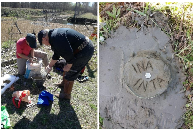
Figura 14.- Elaboración de mojón para ubicar el Punto Fijo
