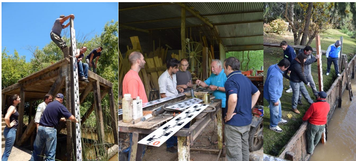
Figura 6.- Instalaciones de escalas en Canal Borches, Canal Seoane y Río Carapachay.
