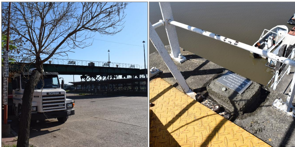
Figura 2.5. Escala hidrométrica 1 (izquierda), bulón y placa instalados (derecha)
