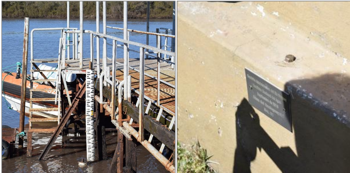
Figura 2.3. Escalera hidrométrica 1 (izquierda), bulón y placa instalados (derecha)
