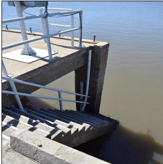
ESCALA HIDROMÉTRICA
