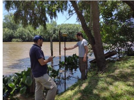
Instalación nuevo sensor hidrométrico automático para registrar las alturas sobre el río Paraná en el predio del INTA Delta
