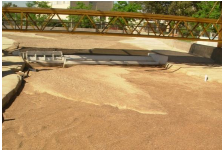
Figura 4.- Barra de sedimentos aguas abajo del foso de erosión, ensayo N°1 – 900 m 3 /s.
