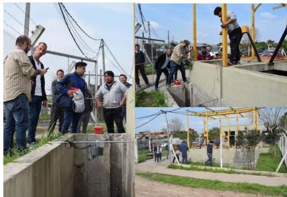
**Figura 2.-** Instalación de sensor de nivel en la estación de bombeo n°4, Quilmes, sobre el Arroyo Las Piedras.
