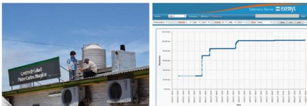
**Figura 3.-** Instalación de pluviómetro (izquierda) y visualización de los registros de precipitaciones (derecha).
