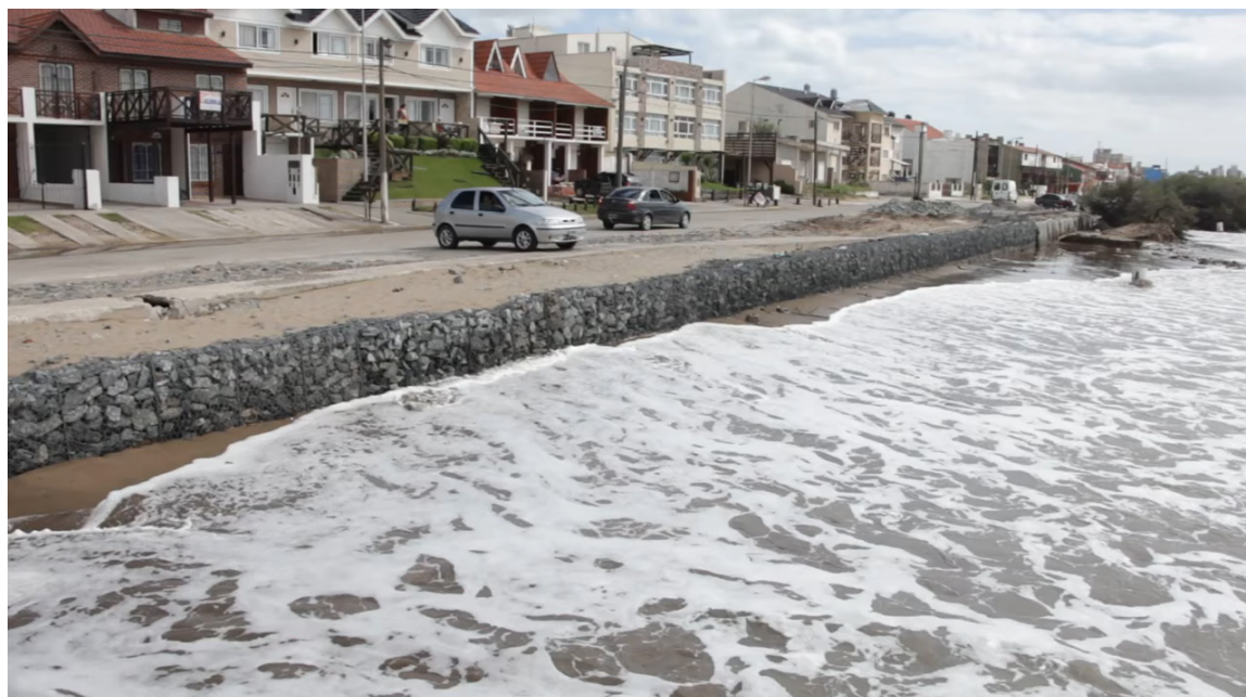
Figura 4.5. Defensa costera con gaviones en el Mar del Tuyú (Partido de La Costa) (Fuente: Canal Once de la Costa).
