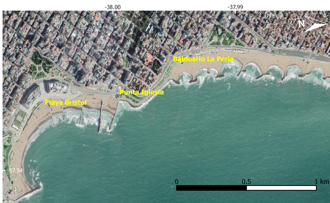
Figura 4.13. Obras de defensa costera en el centro de la ciudad de Mar del Plata.
